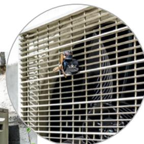
... einen kleinen Propeller am Ventilatorgitter des Außengeräts angebracht hat, der sich dreht, wenn die Wärmepumpe läuft.
