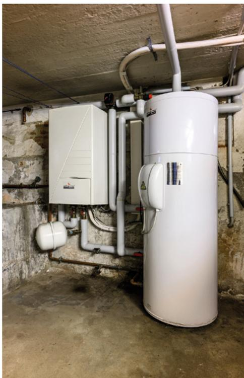
Im ehemaligen Kohlekeller steht die Wärmepumpen-Inneneinheit mit der wandhängenden, kompakten Hydrobox und einem 200 Liter Speicher für die Brauchwasseraufbereitung.
